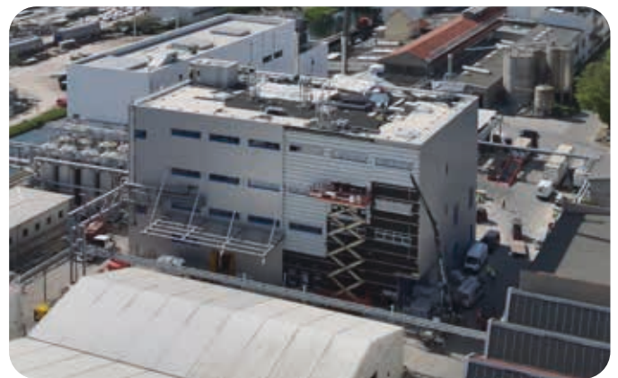
Aufnahmen des Baufelds - Stand Mai 2026
