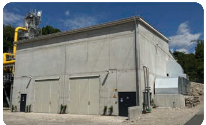
Die neu gebaute Kompressorstation
