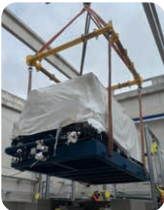
Ein neuer Verdichter (Gewicht 20 t) schwebt behutsam auf sein Fundament
